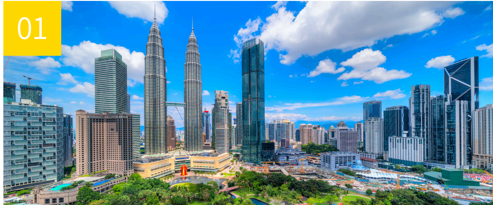
01 ペトロナスツインタワー (KLCC)：高さ452m、88階建ての世界一高いツインタワー。マレーシアの急速な経済発展のシンボルであり、圧巻の美しさです。
